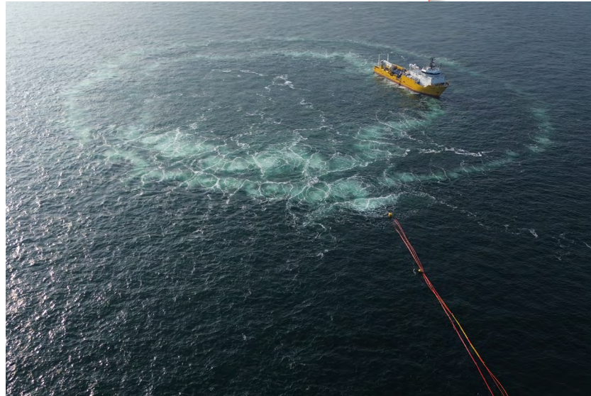
Implementing a double bubble curtain © Vattenfall
