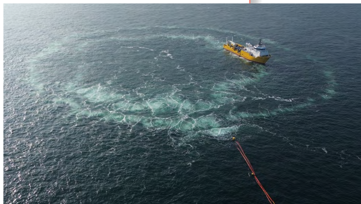
Mise en œuvre d'un double rideau de bulles © Vattenfall
