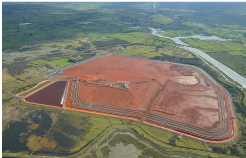
Figure 4 : Zone de stockage des résidus de bauxite, Aughinish, Irlande [19]
